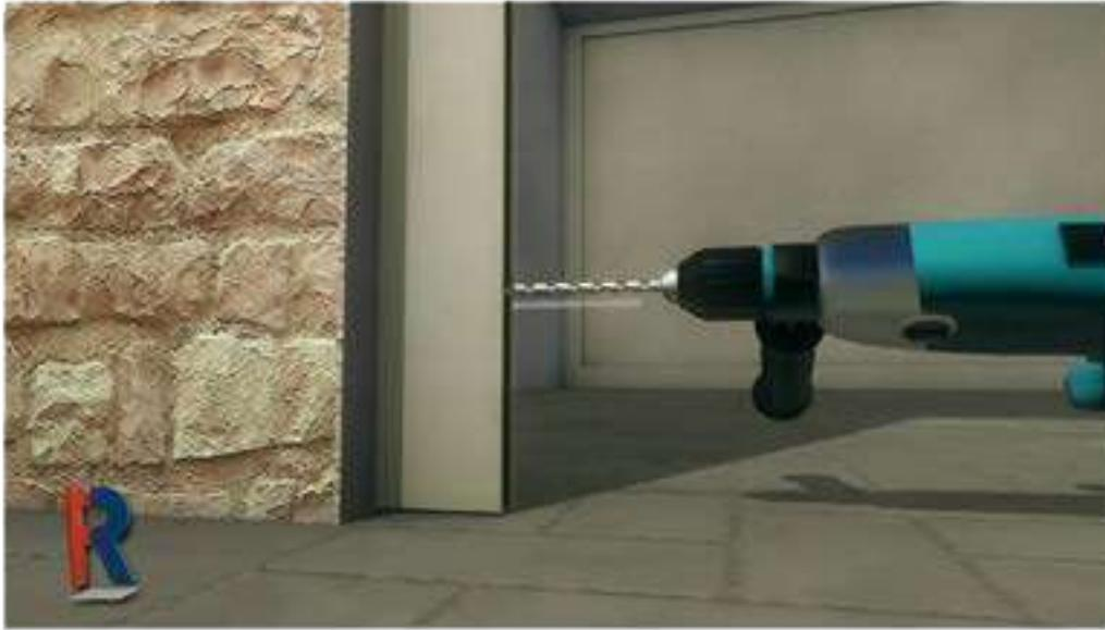
Bohren Sie die Gleisführung alle 50 cm
