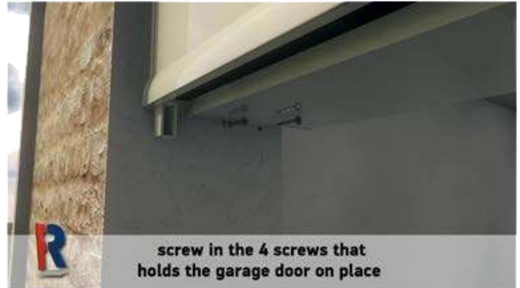
Markieren, bohren und schrauben die vier Schrauben auf beiden Seiten
