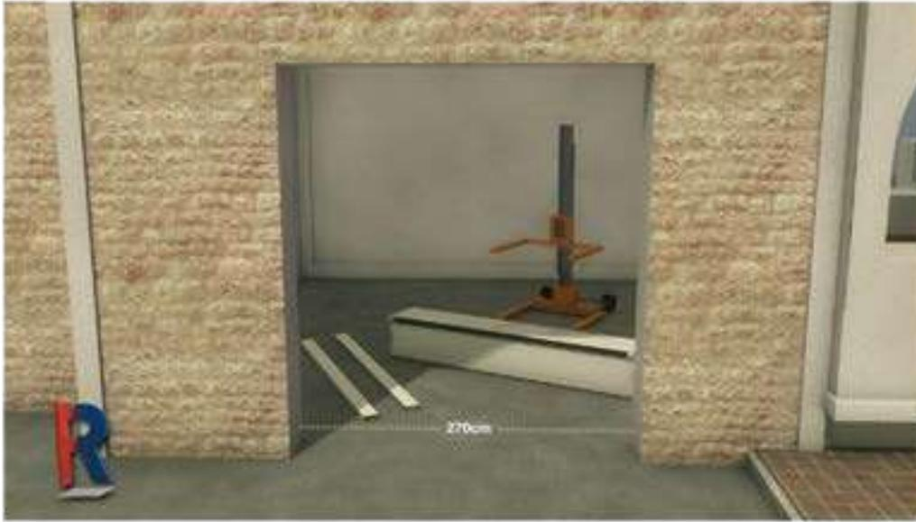
Achten Sie darauf, dass die Abmessung der Öffnung mit der Breite des Garagentors genau gleich ist
